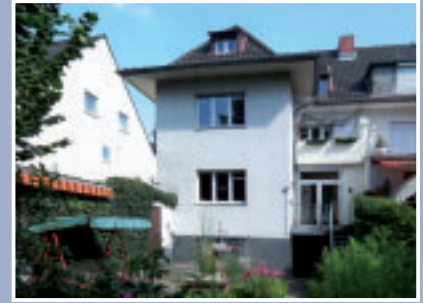
Köln-Weiden, Einfamilienhaus von 1935, weitgehend unverändert, unrenoviert, Wohnfläche 200 m 2 , 9 Zimmer, Areal 475 m 2 , € 310.000,-
